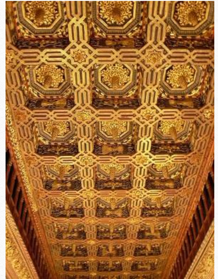
Techo mudéjar en la sala de trono de Aljafería
