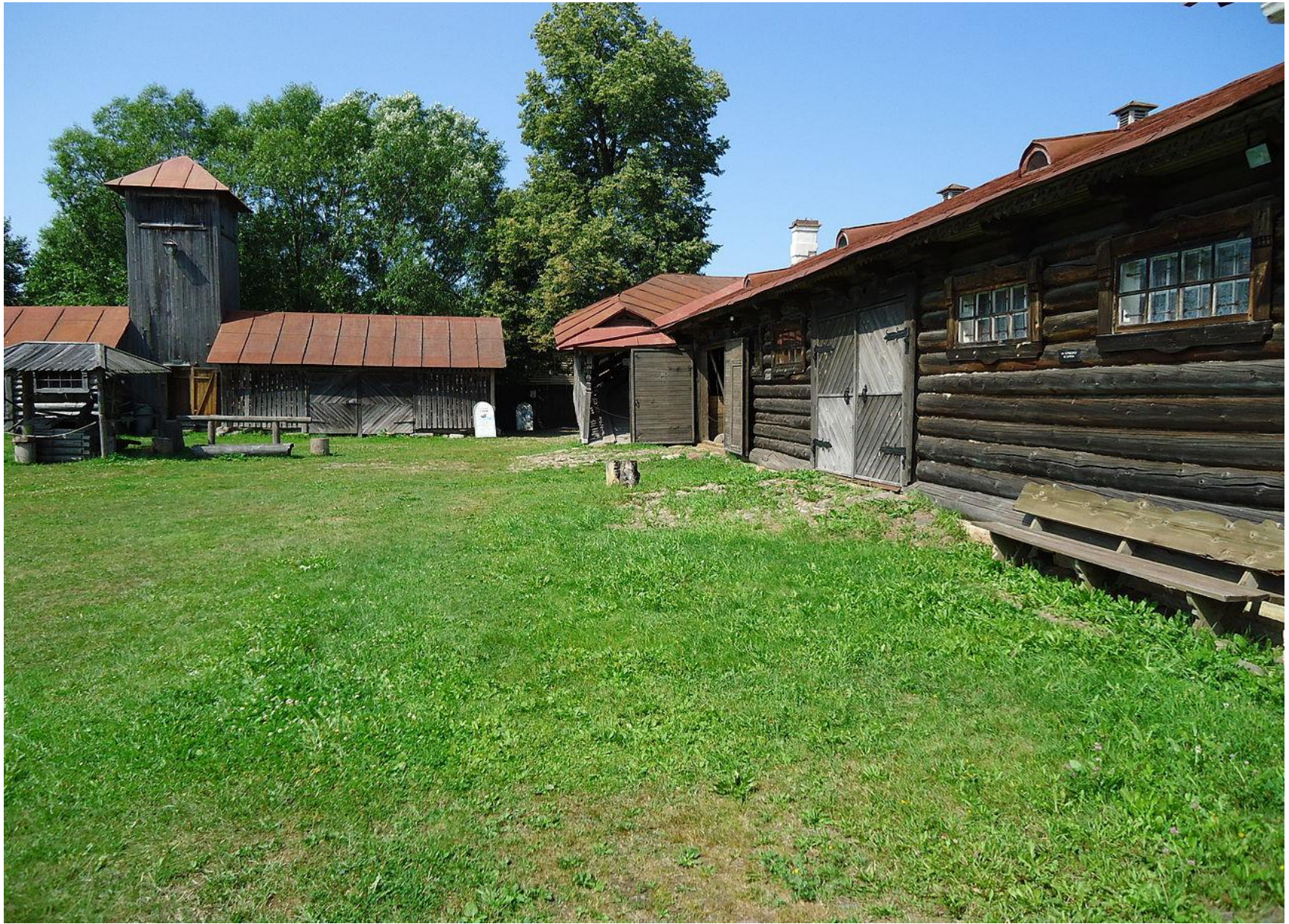
Дом стационарного смотрителя в Выре под С-Петербургом.
