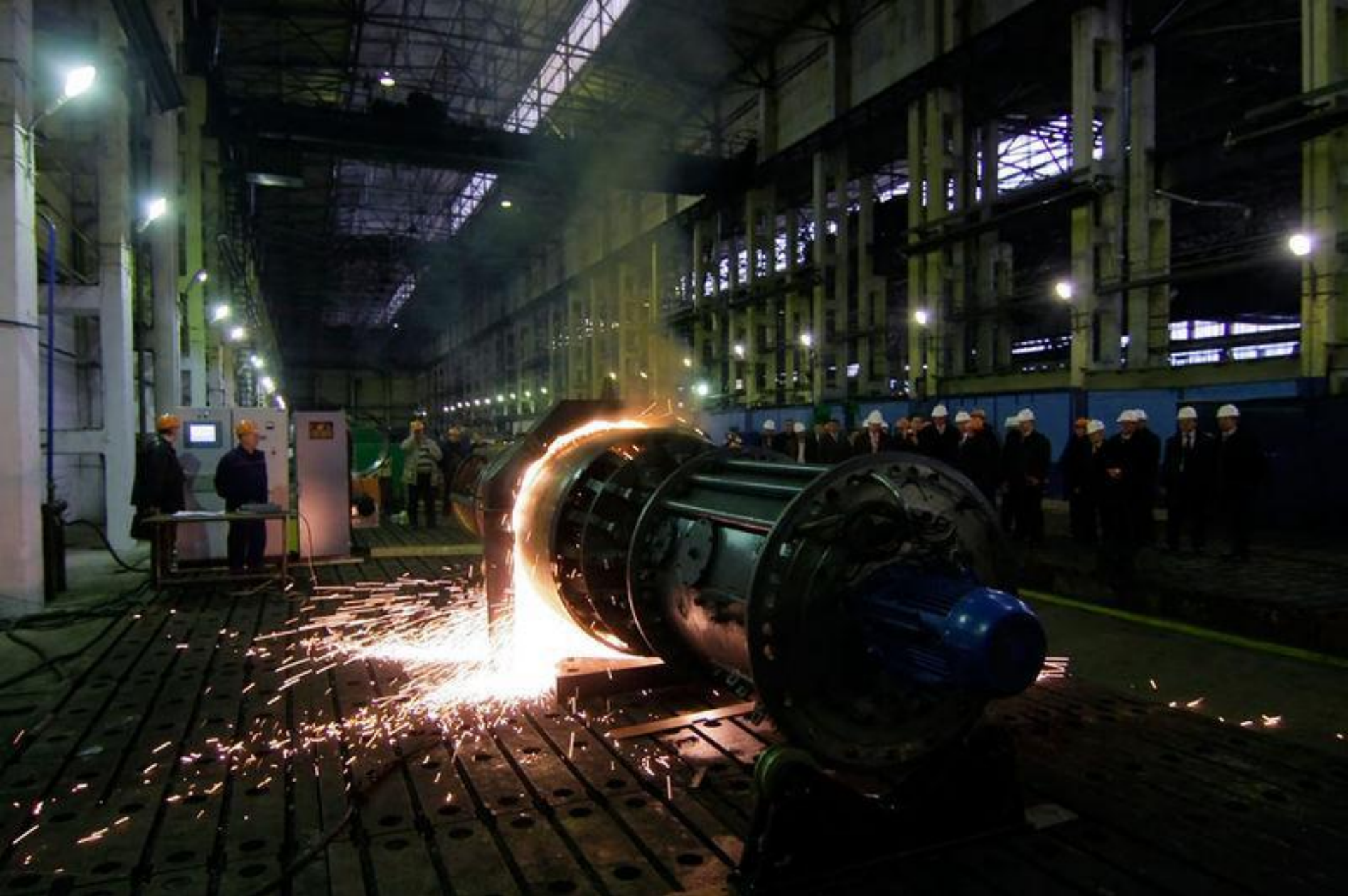
Контактная сварка непрерывным оплавлением трубы газопровода диаметром 1420 мм во Пскове на ПЗ ТЭСО
