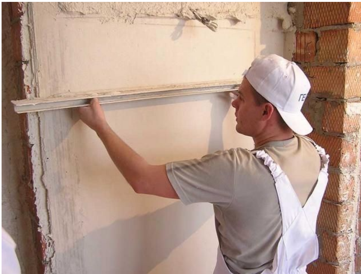
Выравнивание стен
