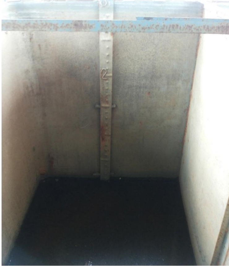
Объем градуированного мерного бака: 6 \text{ м}^3 (по 3 \text{ м}^3 каждый)
