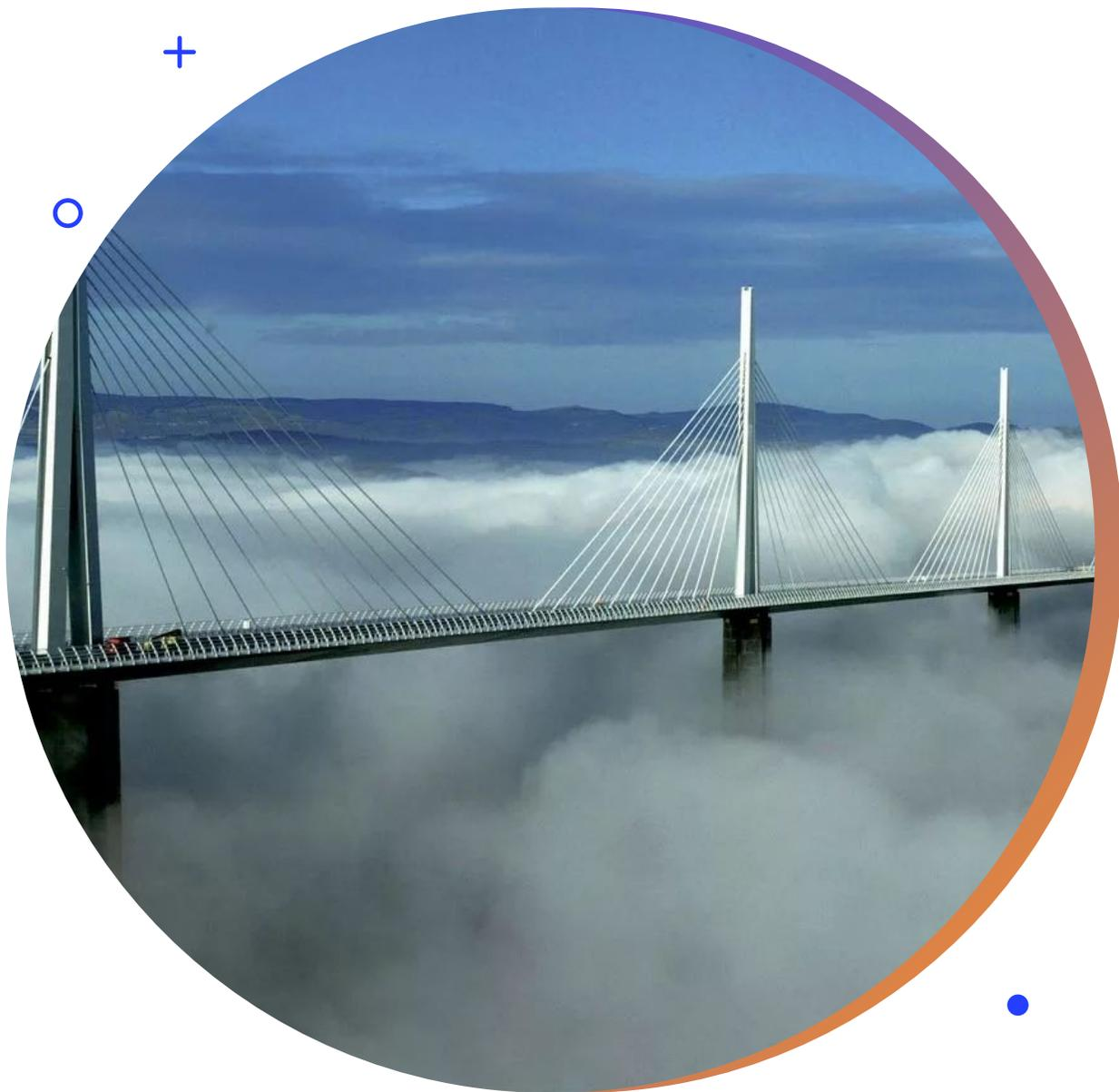
Каждая из опор поддерживает пилоны высотой 97 метров. Сначала были собраны колонны вместе с временными опорами, затем части полотна выдвигались через опоры при помощи гидравлических домкратов, управляемых со спутника, на 600 миллиметров каждые 4 минуты. Для крепления временных опор были использованы преднапряженные стержни диаметром 32, 50 и 75 мм.
