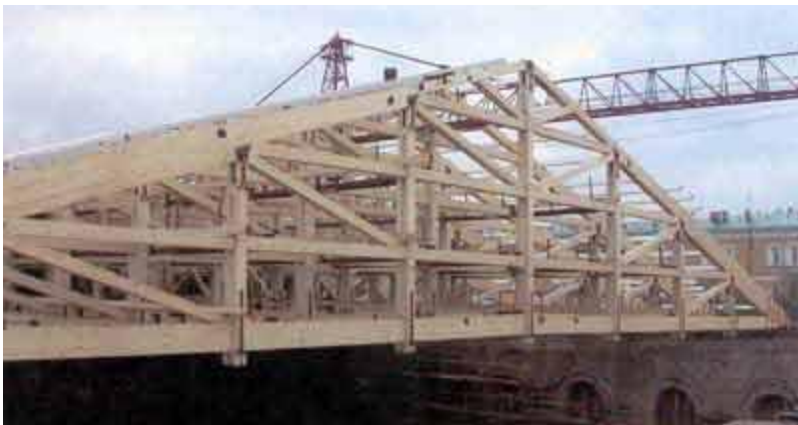
Ферма-балка с металлодеревянными раскосами
