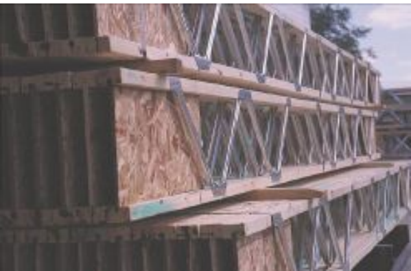
Ферма-балка с металлодеревянными раскосами
