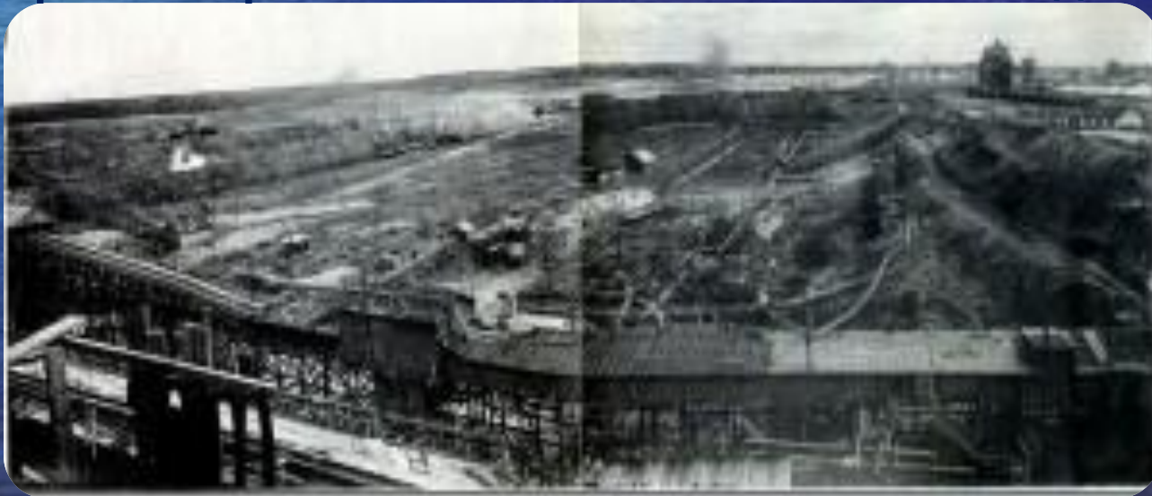
Строительство рыбинской плотины
