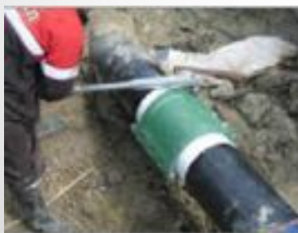
Тарированная протяжка болтов по схеме
