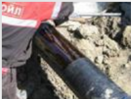
Нанесение клеевого состава
