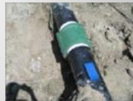
Муфта смонтирована. Магнитный маркер установлен
