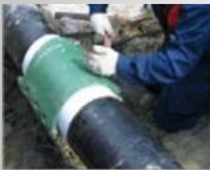
Предварительная затяжка болтов
