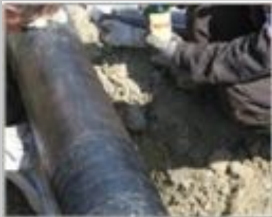
Очистка дефектного участка от изоляции и его обезжиривание
