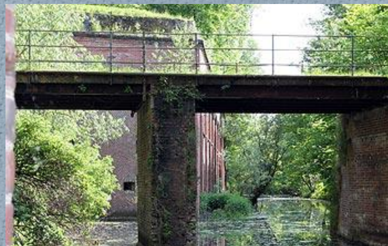
некогда подъемный мост
