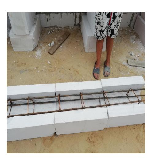
• На подставку из дерева ставятся блоки с у-образным вырезом внутри. Далее укладывается арматура и заливается бетоном. На этот ряд блоков укладывается следующий ряд.
