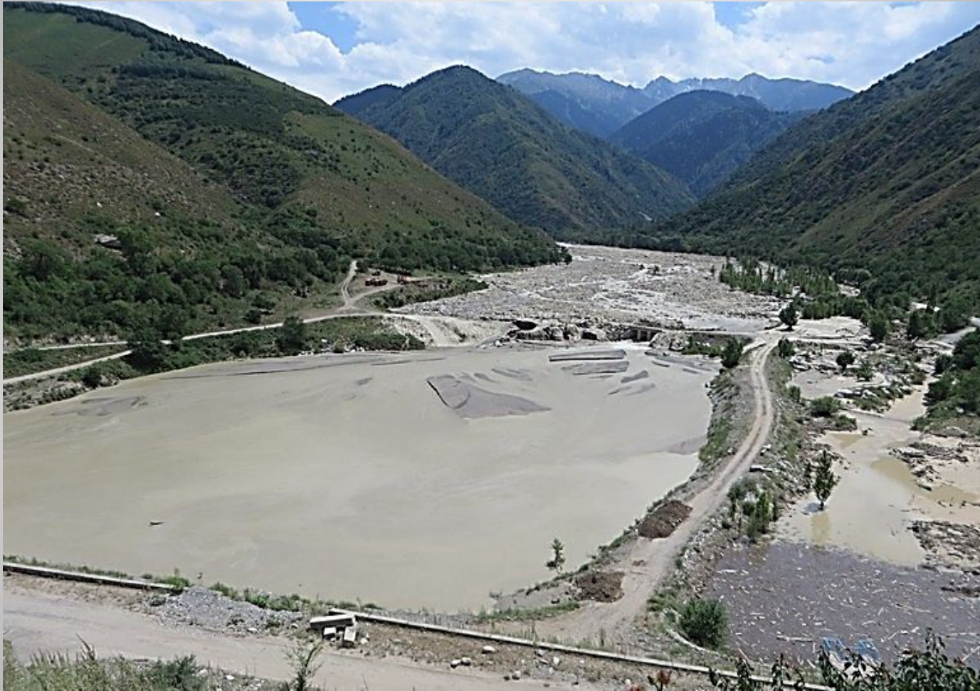
Отложения гляциального селя 2014 г. в селехранилище перед плотиной Талгар. Казахстан.
