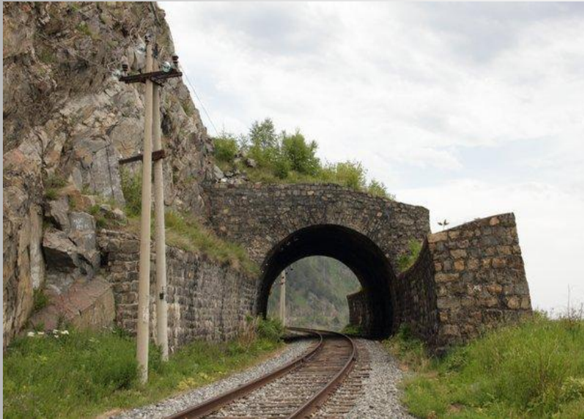
Противообвальная галерея арочная.
