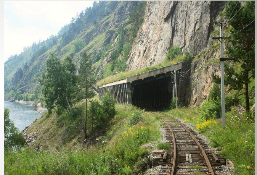
Противообвальная галерея балочная.
