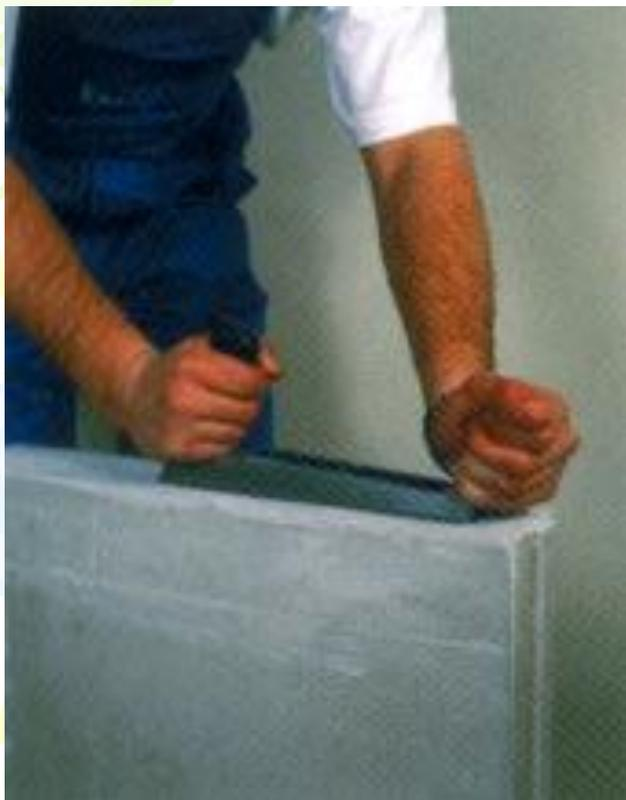
6. Плиты первого ряда укладываются на пробковую прокладку с нанесенным на нее раствором шпаклевки
