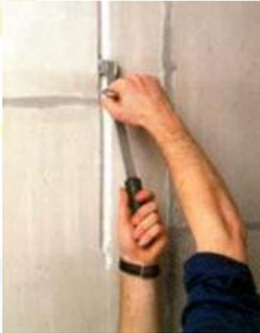
Электрическая и слаботочная проводка в перегородках (облицовках) из гипсовых плит монтируется скрытно в штробах. Эти работы проводятся до начала проведения отделочных работ. Штробы под проводку устраиваются при помощи бороздодела (ручного или механического), после монтажа проводки штробы зашпаклевываются.
