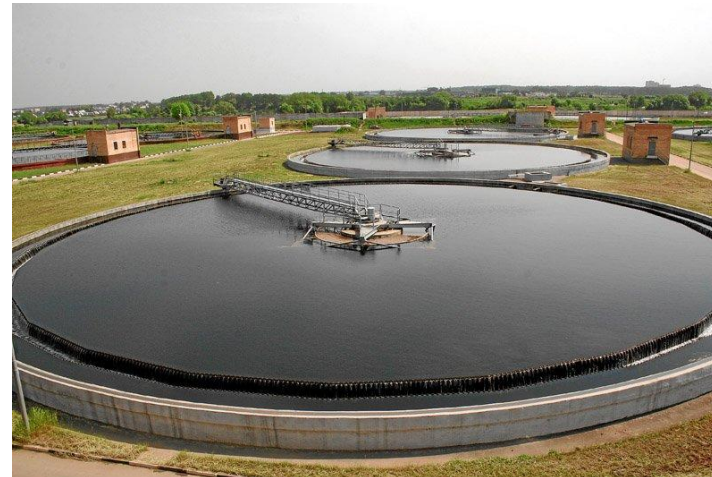
Отстойники для сточных вод
