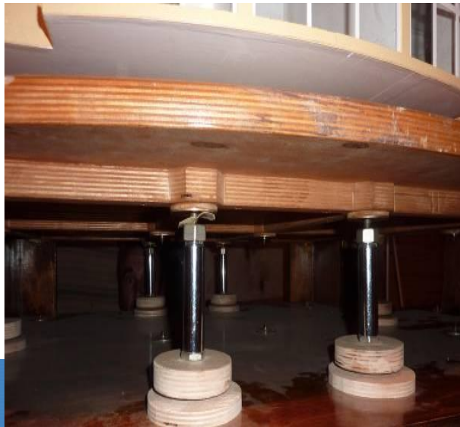
Положение сейсмоизолирующих опор модели при завершении испытаний на динамические смещения основания, соответствующих 9-ти балльным сейсмическим воздействиям
