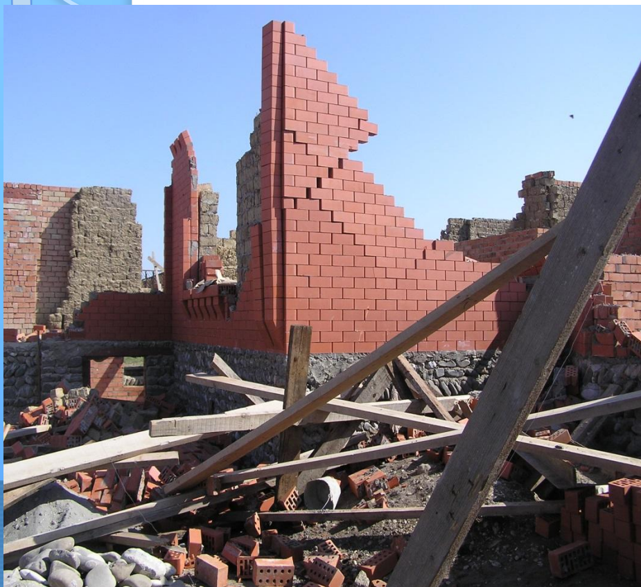
Одноэтажное саманное здание, облицованное кирпичом после землетрясения в с. Майртуп
