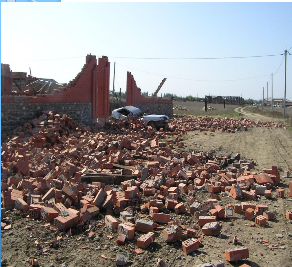
Разрушенное землетрясением здание в с. Майртуп
