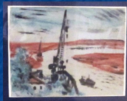
Строительство моста через р.Вятку
