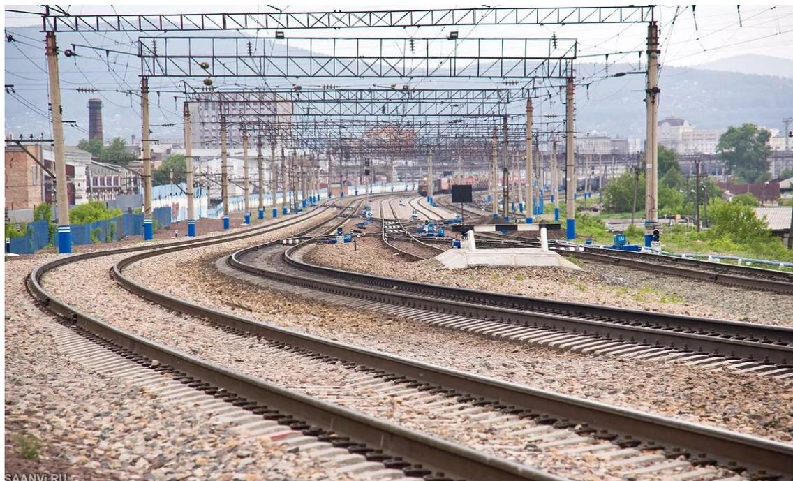
На участках со сложным планом пути, на которых протяженность кривых с радиусом менее 350 м составляет более 20% всего протяжения, или протяженность всех кривых - более 40%, при прочих равных условиях класс пути повышается на один класс.
