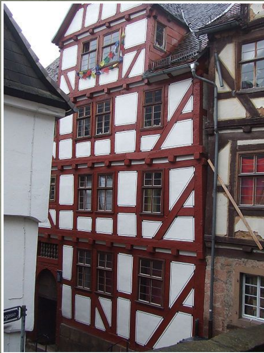
Дом, в котором жил Ломоносов в Марбурге.
