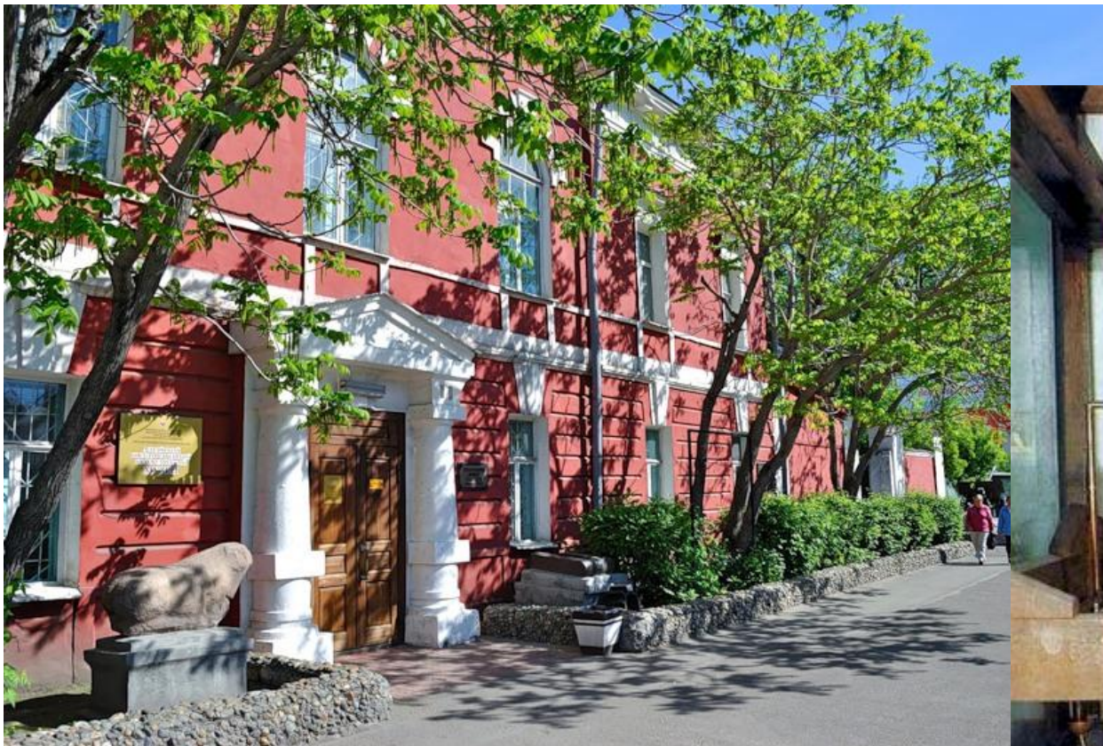
Алтайский краеведческий музей (бывшее здание химической лаборатории Алтайских заводов), ул. Ползунова, 46.
