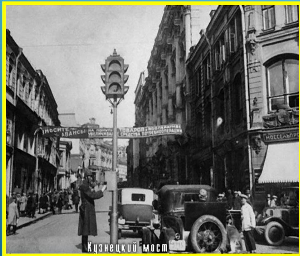
Конструкция этого светофора была выполнена в виде циферблата часов, разделенного на секторы зеленого, желтого и красного цветов. Переключение между цветами осуществлялось с помощью стрелки (как у часов)
