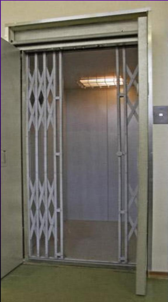
Лифт – грузоподъемная машина для вертикального или наклонного перемещения грузов на специальных платформах, передвигающихся по жёстким направляющим.
