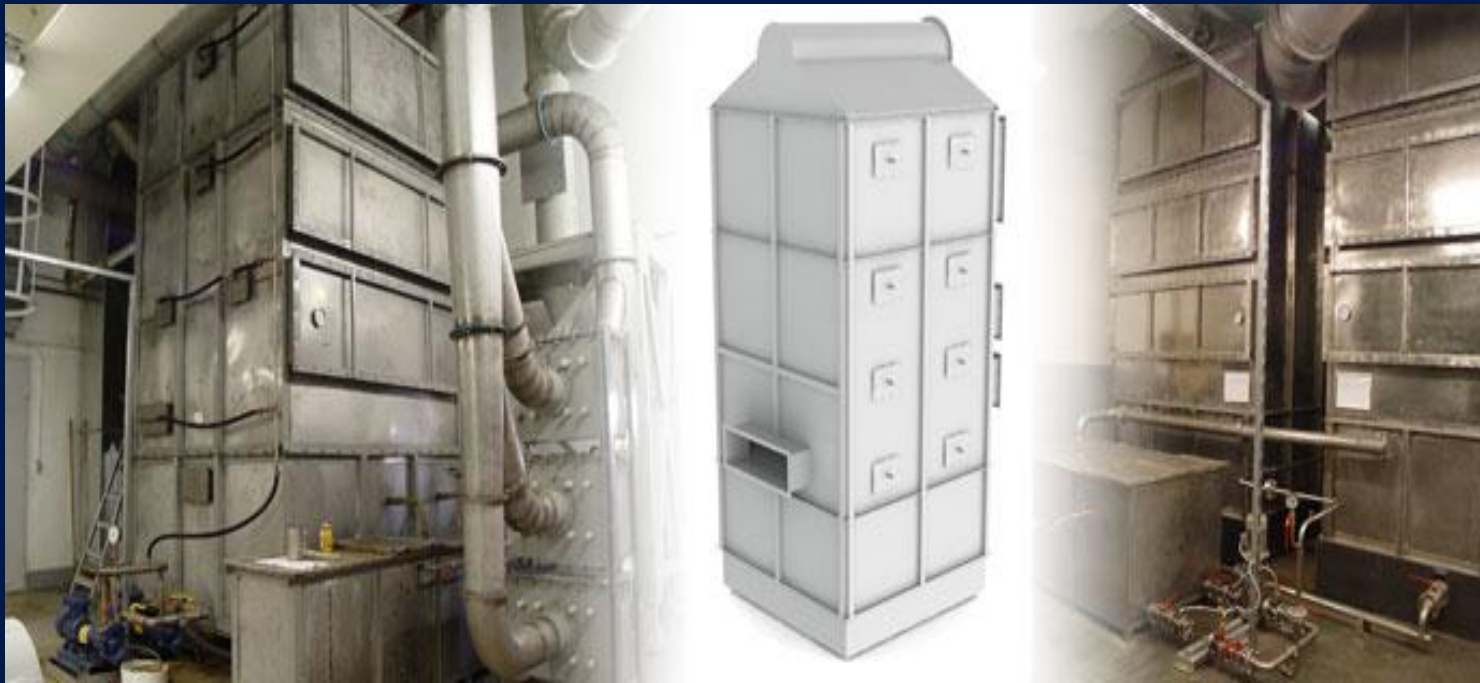
Установка биологической очистки выбросов воздуха - биофильм
