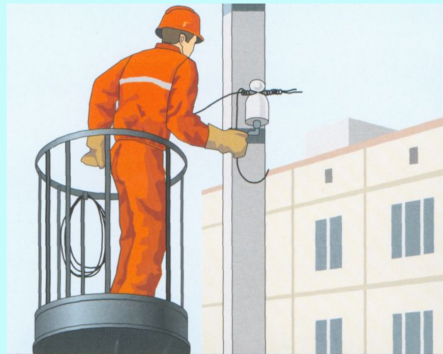
Ремонт и восстановление повреждённых и разрушенных линий связи и коммунально-энергетических сетей в целях обеспечения аварийно-спасательных работ
