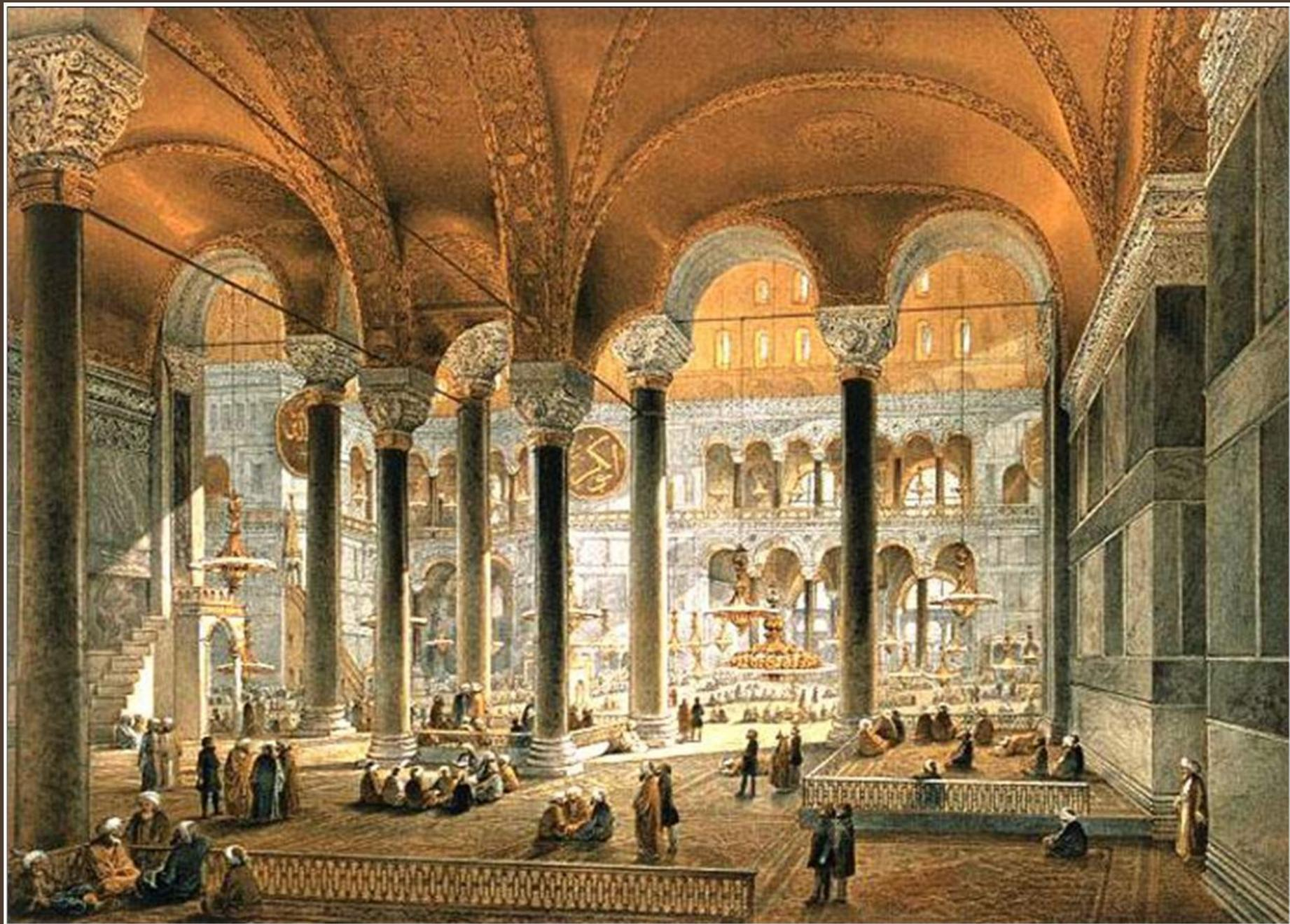
В плане собор представляет собой крест, 70x50 м. Это трехнефная базилика с куполом диаметром 32 метра. Сложность заключалась в грандиозных размерах постройки. Основную нагрузку несут многочисленные хитросплетенные арки и своды. В направлении восток-запад распор гасится так - к центральному куполу с двух сторон примыкают два больших полукупола, к ним, в свою очередь - меньшие полукупола. Сила распора растекается, дробится до тех пор, пока ее не принимают на себя специальные колонные пилоны
