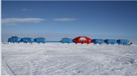
Модульная британская станция Halley VI
