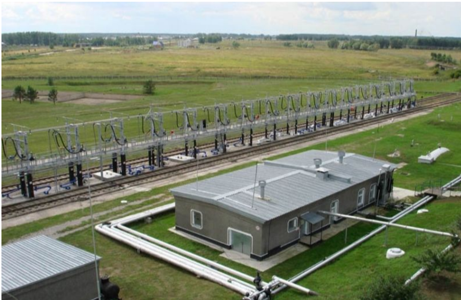
Железнодорожная сливно-наливная эстакада для нефтепродуктов
