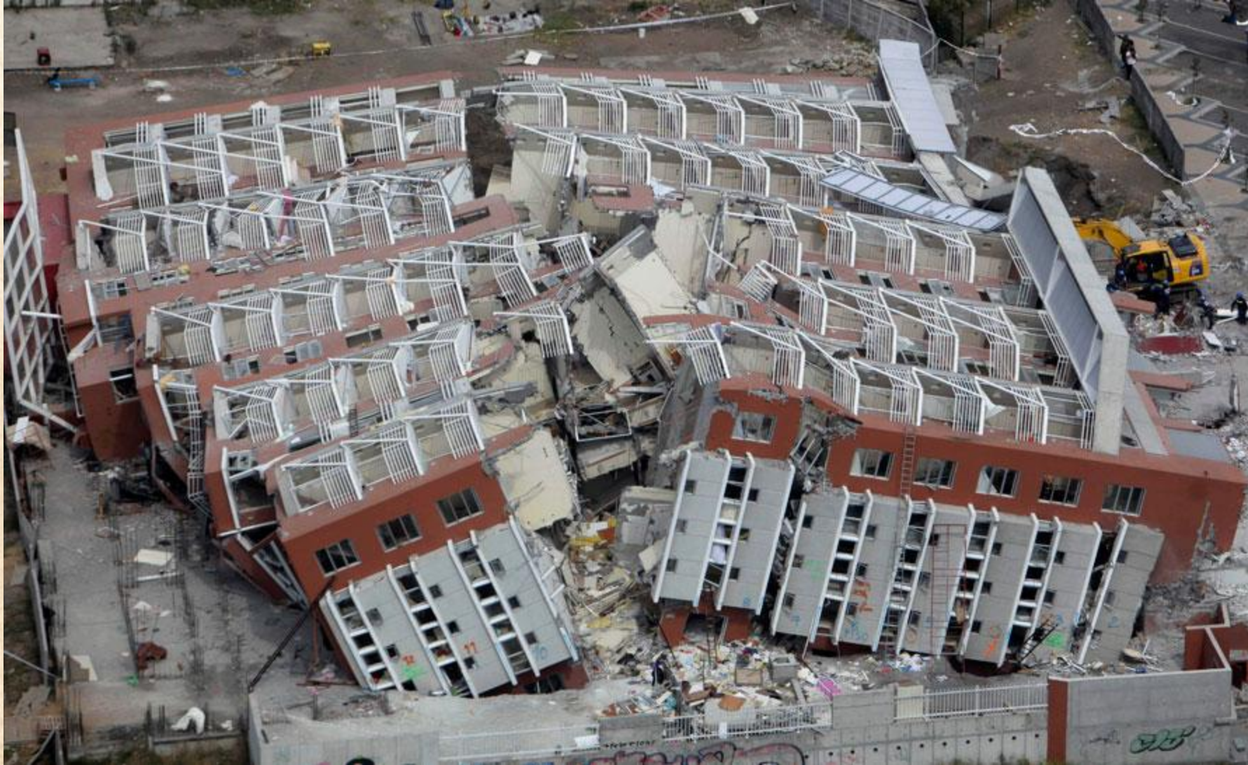
Разрушенное здание в Консепсьоне после землетрясения в 8,8 баллов в Чили
