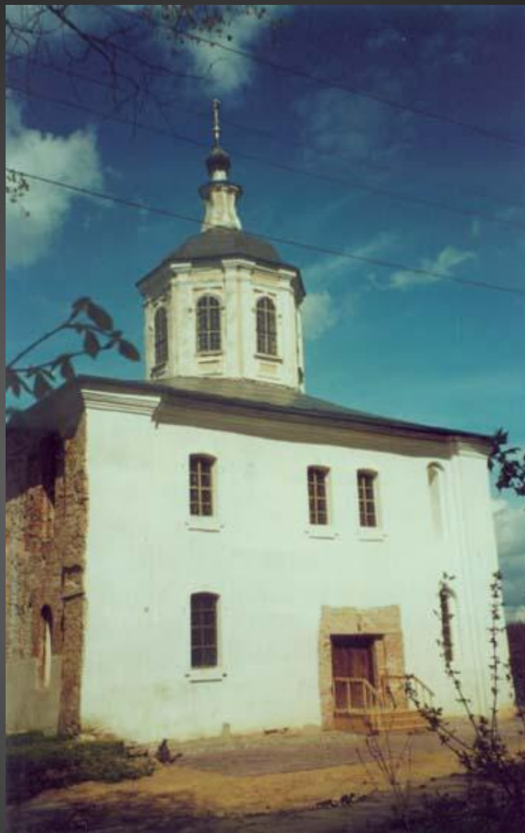
Церковь Иоанна Богослова. Смоленск. 70-е гг. XII в. Западный фасад.
