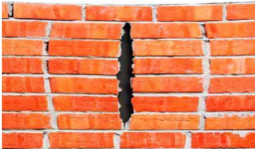
Рисунок 8(г) - Кирпичная кладка
