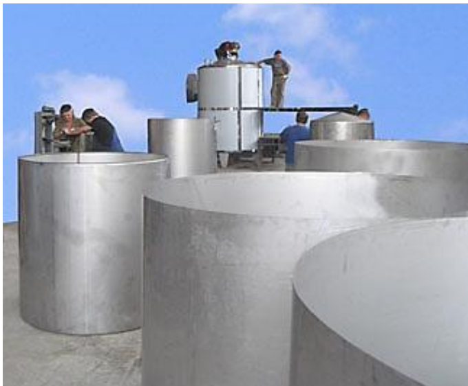
Сборка металлических резервуаров
