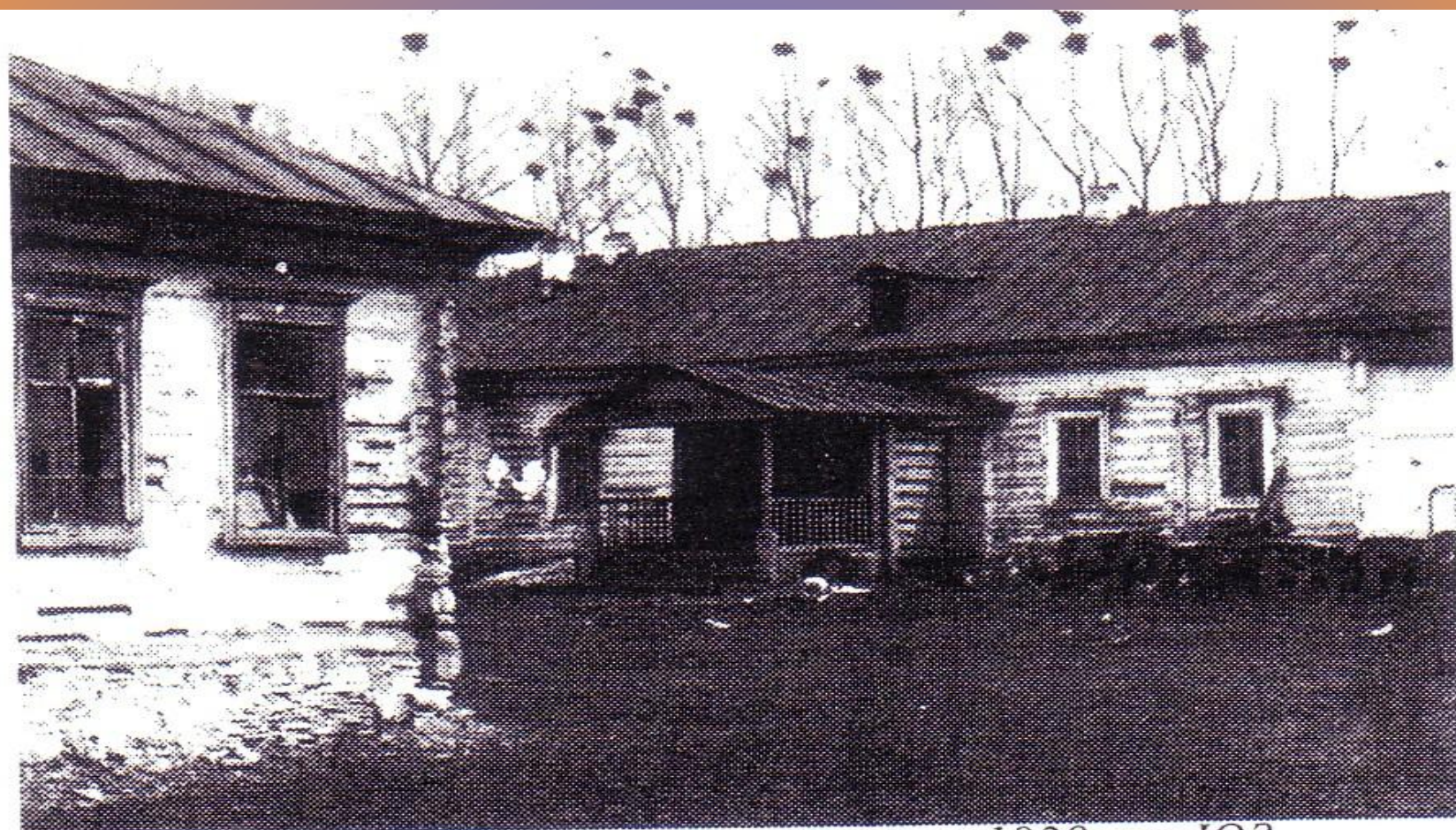
Основное здание, построенное в 1939 г. с ЮЗ
