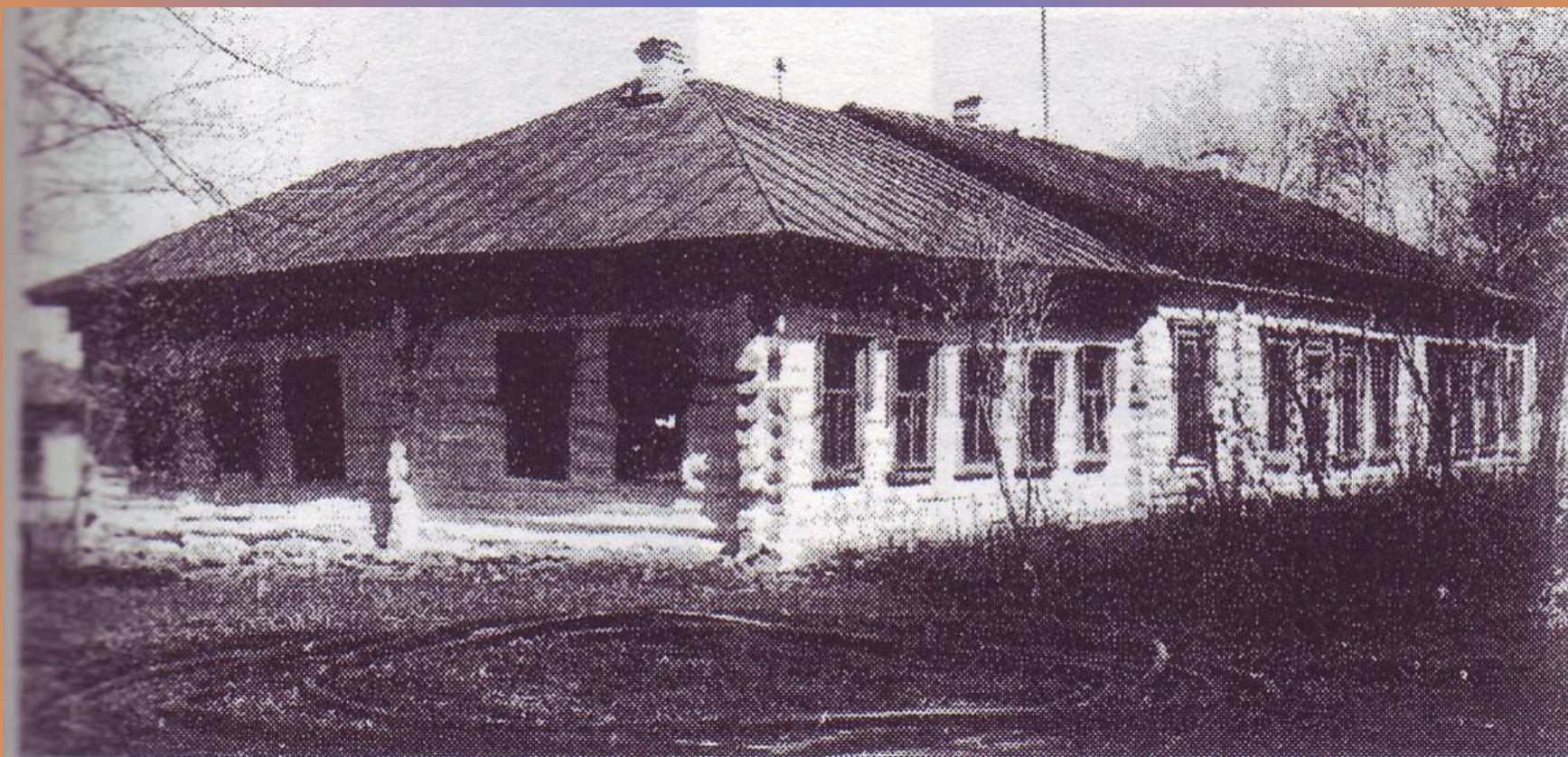
Основное здание, построенное в 1939 г. с ЮВ
