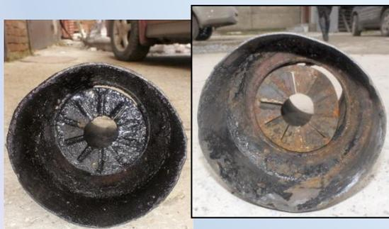
Очистка горелки твердотопливного котла
