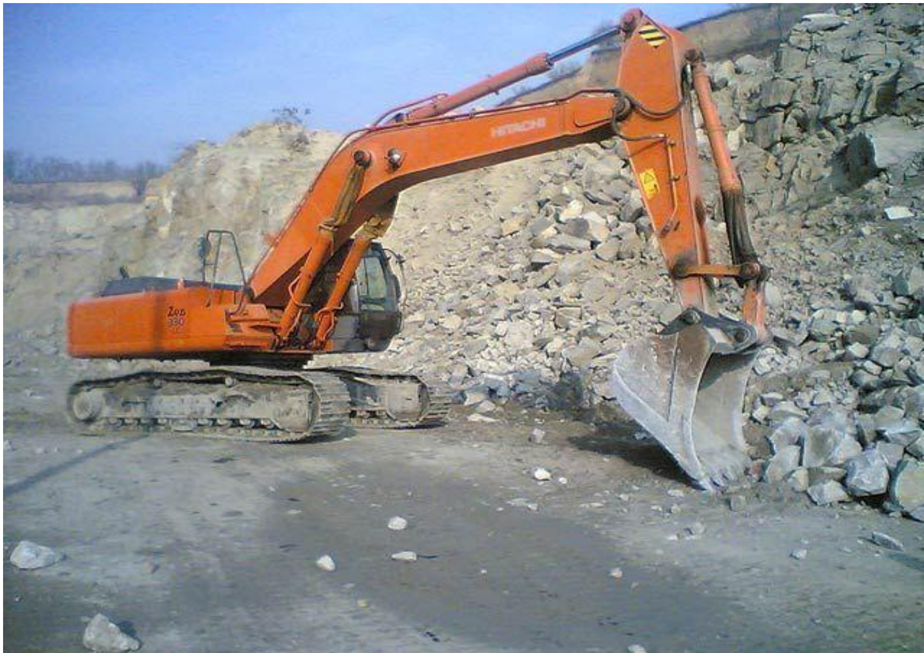
Рис. 5. Экскаватор гидравлический с прямой лопатой на гусеничном ходу
