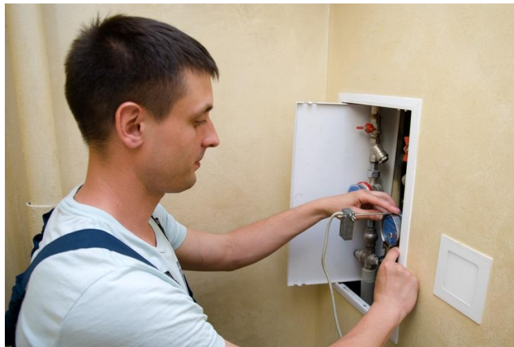
Встановлення блоку камери на лічильник
