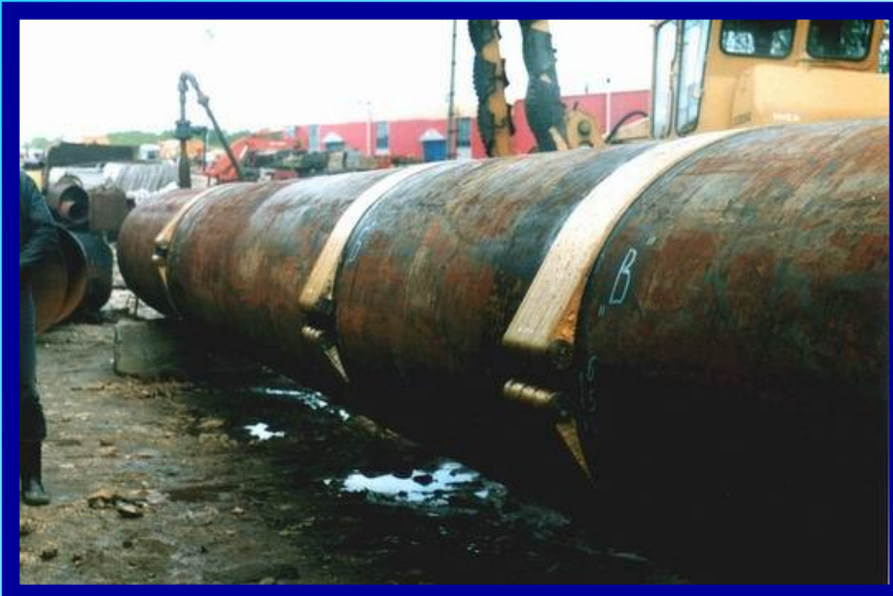
Плеть трубы с муфтами РСМ-1220
