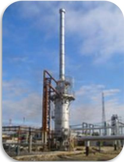
При подводе тепла в низ колонны трубчатой печью часть кубового продукта прокачивается через трубчатую печь, и подогретая парожидкостная смесь (горячая струя) вновь поступает в низ колонны. Этот способ применяют при необходимости обеспечения сравнительно высокой температуры низа колонны, когда применение обычных теплоносителей (водяной пар и др.) невозможно или нецелесообразно (например, в колоннах отбензинивания нефти).
