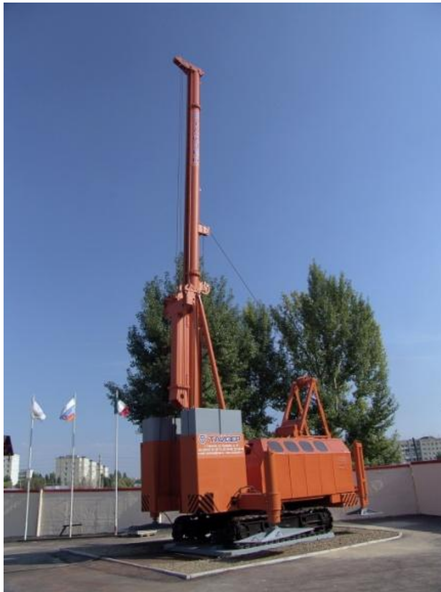
Рис. 6. Погружение свай статическим вдавливанием
