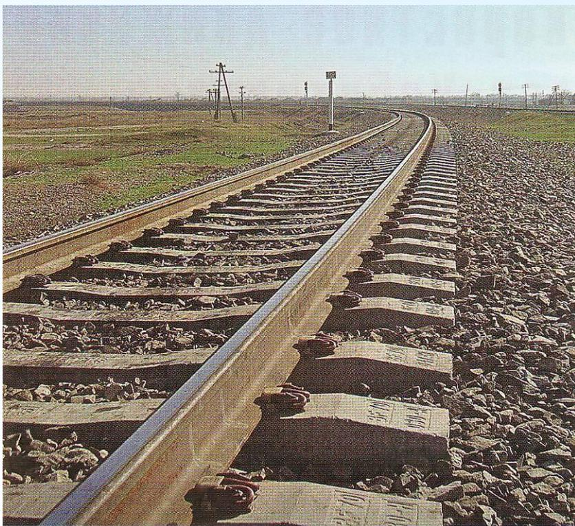
В качестве основной конструкции верхнего строения пути на участках скоростного и высокоскоростного движения приняли железобетонные шпалы типа **BF70** с промежуточными рельсовыми скреплениями **Pandrol Fastclip** (Великобритания) и рельсы **R65**.
