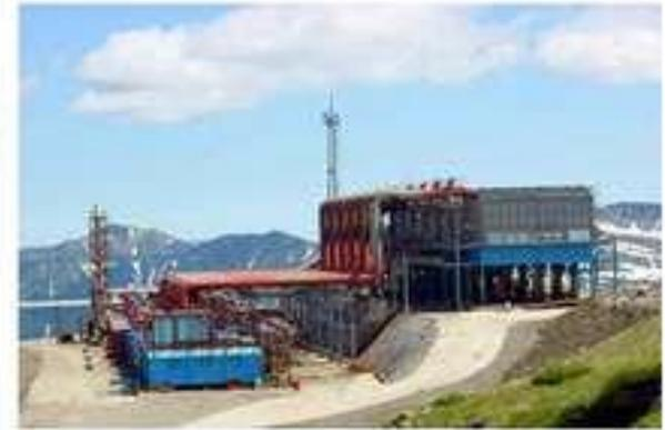
*Геотермальная электростанция. Теплоноситель закачивается в горячие слои и переносит тепловую энергию в теплообменник (Heat Exchanger) где передаёт её воде, превращая в пар. Далее паровая турбина и электрогенератор*
