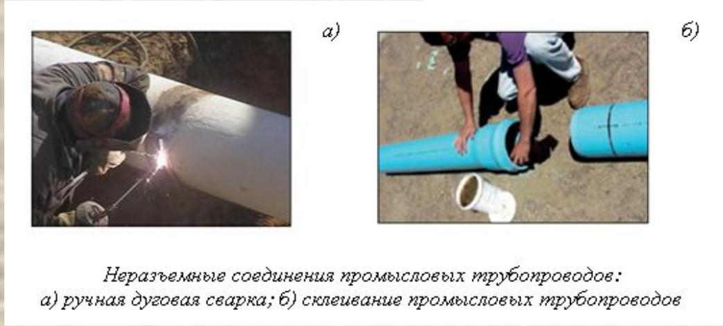
*Неразъемные соединения промышленных трубопроводов:
