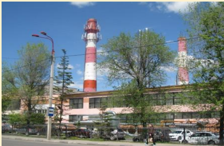
Котельная №21 ул. Звездная
