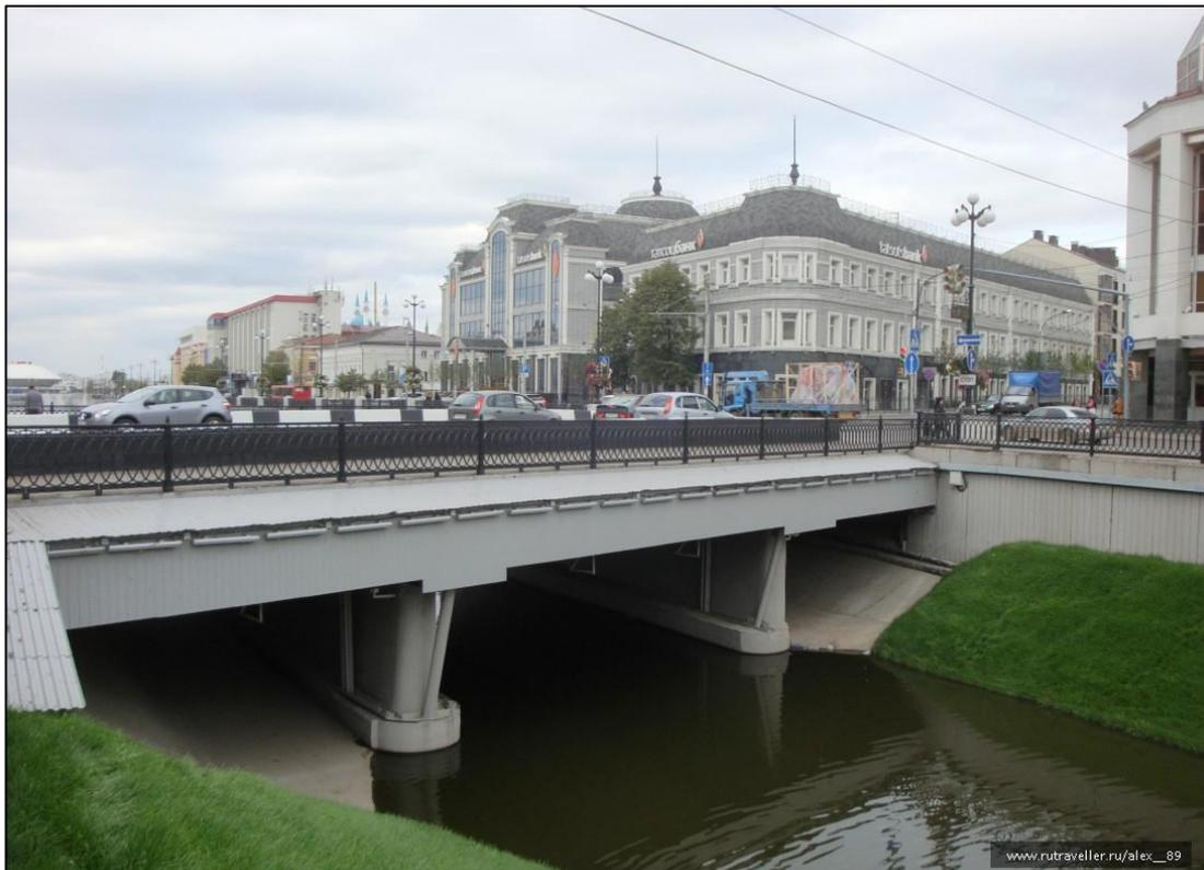
Этот мост представляет собой железобетонное сооружение с чугунными перилами, переброшенное через русло реки. Несущую часть моста поддерживают три бетонных опоры, по мосту осуществляется движение автотранспорта и пешеходов.
