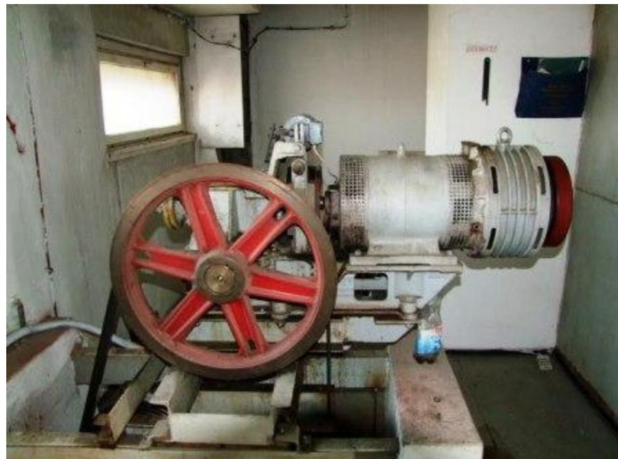
При выборе ЭП постоянного тока часто используются тихоходные двигатели, частота вращения которых совпадает с требуемой частотой вращения канатоведущего шкива, что исключает необходимость применения понижающего редуктора. Это упрощает механическую передачу и уменьшает потери мощности в этой передаче. Система получается достаточно бесшумной.
