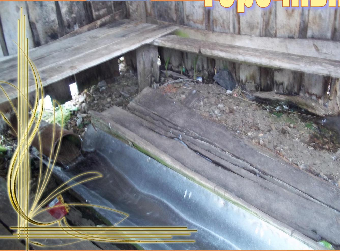
В основание колодчика положена труба большого диаметра, по которой вода вытекает из деревянного сруба и не дает ей переливаться через верх. Вода течёт из трубы в большую деревянную колоду с металлическим желобом, где удобно полоскать бельё.
