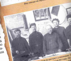
Герой Труда Ф.Д. Хонина (в центре) с учениками Фабрицы. Восстанавливает оборудование на заводе 84 года. Член Пермского Союза генерал-полковника инженерных войск, уроженца Очёра
