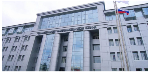
Челябинский трубопрокатный завод
