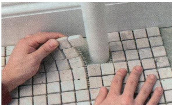
Удалите элементы мозаичной плитки при укладке вокруг трубы
