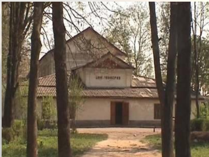
Покровская церковь г. Остров 2006 г.
