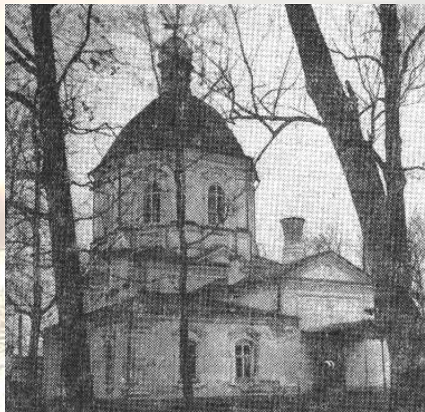
Покровская церковь г. Остров 1936 г.
