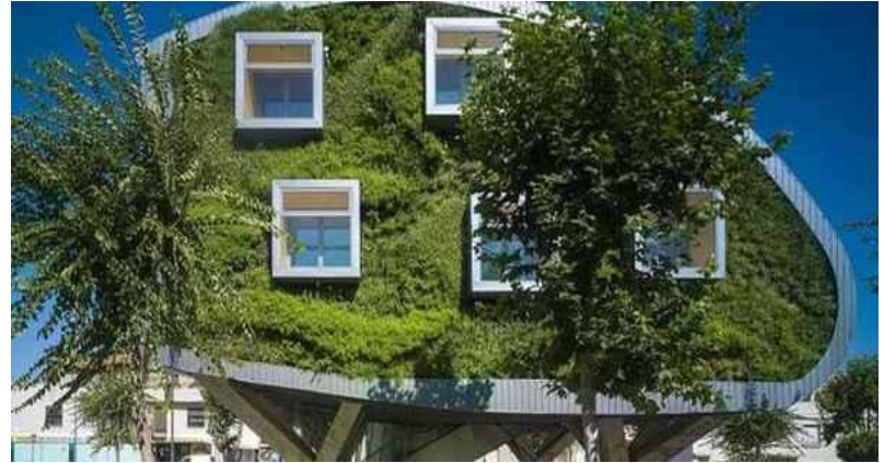
Зелёная архитектура. Офисное здание, Малага, Испания
