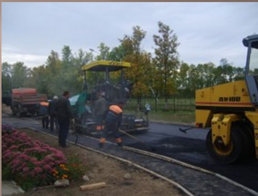
падчас укладкі асфальтавага пакрыцця на тэрыторыі новай раённай бальніцы
