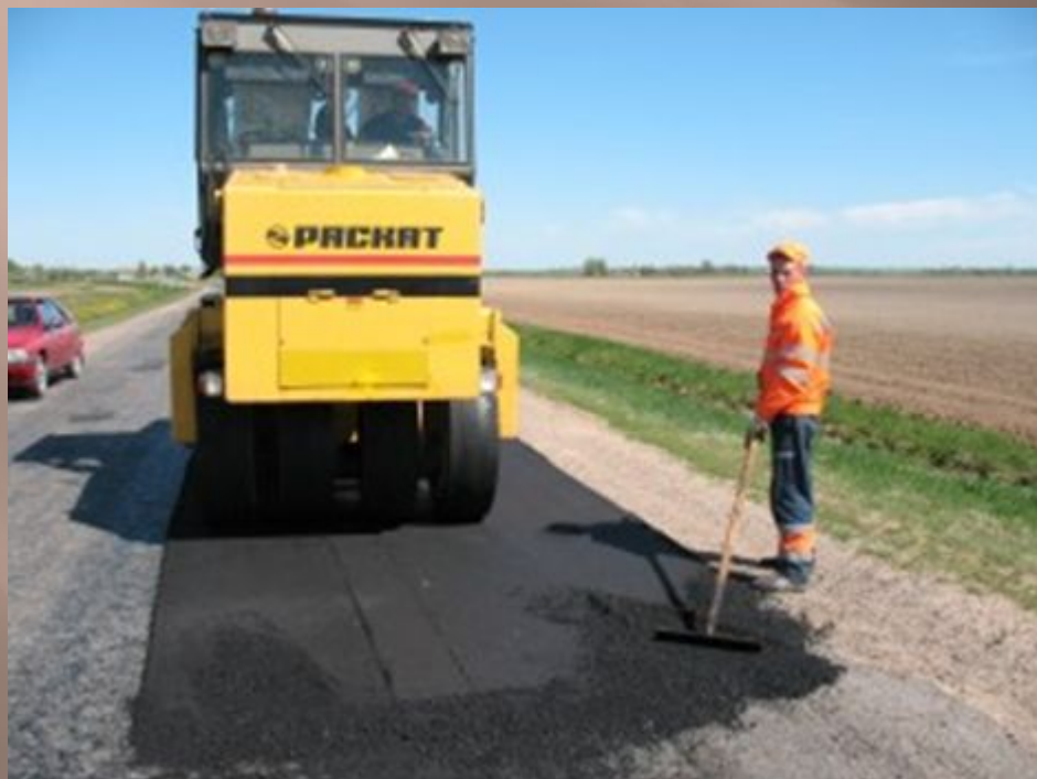
на асабліва пашкоджаных участках даводзілася ўкладваць асфальтавае пакрыццё на некалькі дзясяткаў метраў
